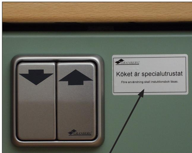
Apposer l'autocollant indiquant qu'il s'agit d'une cuisine spécialement équipée près du bouton de commande.
