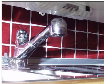
Pensez à faire pivoter le mitigeur le long du mur avant d'abaisser le caisson équipé du VERTI.
